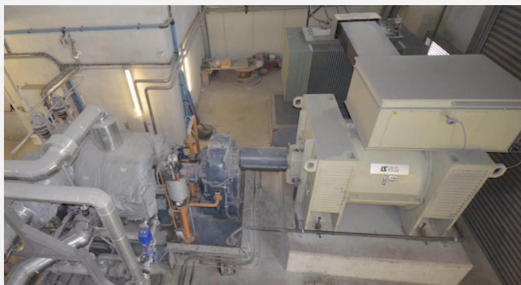
La turbo-alternateur de Carbonex à Gyé-sur-Seine, 3,3 MWé, photo Frédéric Douard
