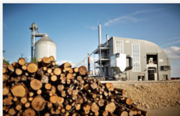
Vue de la centrale de Gué-sur-Seine depuis le parc à bois, photo Carbonex
