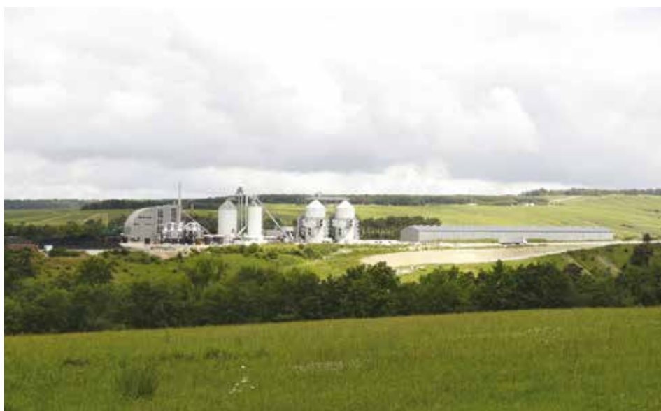
Sur les hauteurs de Gyé-sur-Seine, Carbonex a considérablement renforcé ses installations.
